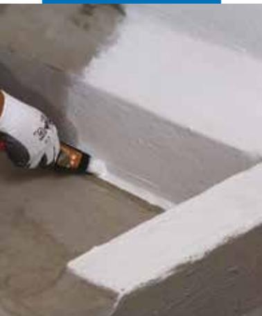
Applicazione di Triblock P nel raccordo tra platea e muro di elevazione
